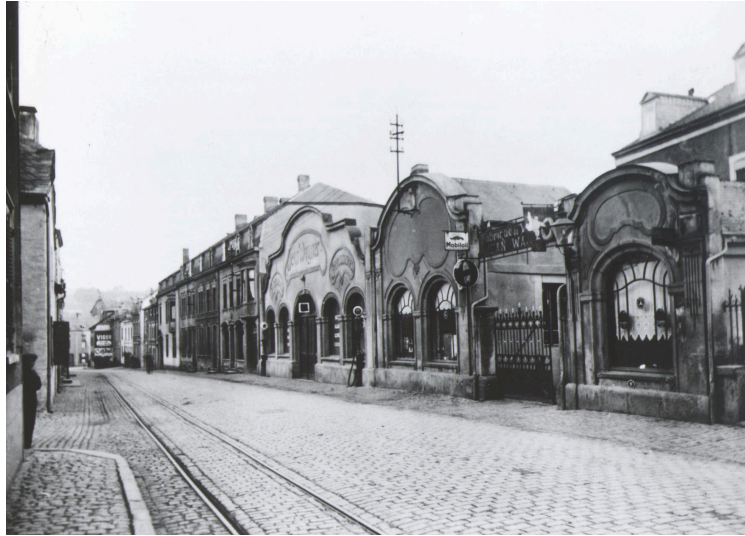
Le Garage WAGNER, un des premiers concessionnaires mondiaux des voitures BENZ, avec sa façade et ses fenêtres style « Art Nouveau » dans la rue de Stavelot à Diekirch. Actuellement, l'ancienne « Fabrique de Voitures JEAN WAGNER » abrite le « Conservatoire National de Véhicules Historiques ». Noter la présence des rails de la voie ferrée métrique Diekirch-Vianden exploitée de 1889 à 1948. [Photographie: NN]
