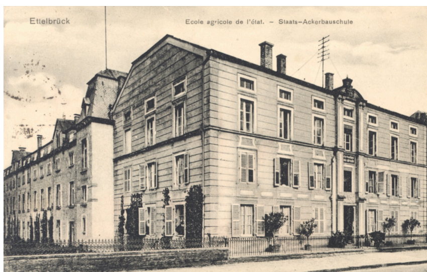
Ecole agricole de l'Etat à Ettelbruck. De face, l'administration et le pensionnat, à gauche, l'école et les champs d'application. [Photographie: NN; nbi]
