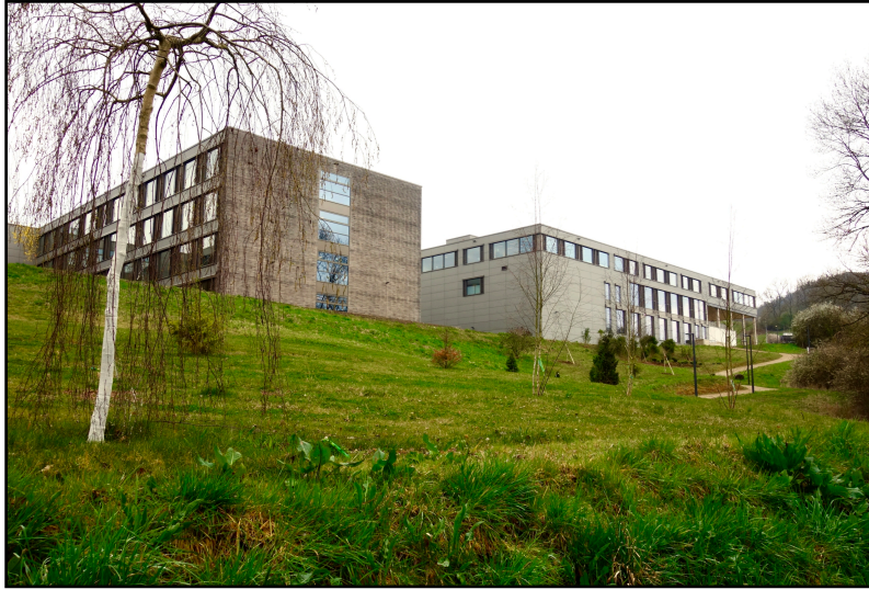
Le nouveau Lycée technique agricole (LTA) implanté sur les hauteurs au sud de Diekirch, au lieu-dit op Kréiwénkel, sur le territoire de la commune de Bettendorf, section Gilsdorf, peu de temps avant sa mise en service. [Photographie: bp_2022-03-30]
