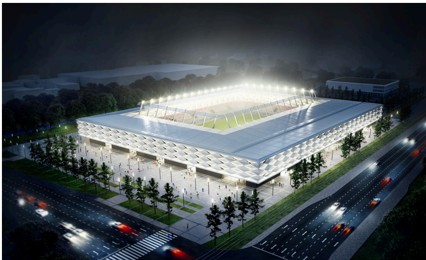
Nouveau stade national de football et de rugby imaginé par gmp – architekten von Gerkan, Marg und Partner et le bureau d'architectes BENG. [Image: Ville de Luxembourg, Stade de Luxembourg]
