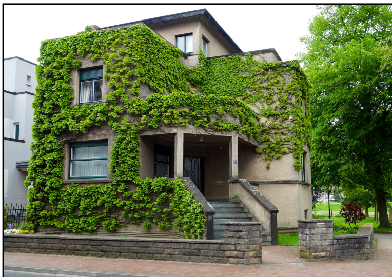
Maison KROMBACH (initialement MONGENAST), 15 avenue de la Gare, avant rénovation. [Photographie: bp_2013]
