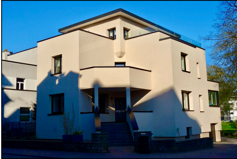
Maison KROMBACH (initialement MONGENAST), 15 avenue de la Gare, après rénovation. [Photographie: bp_2019]
