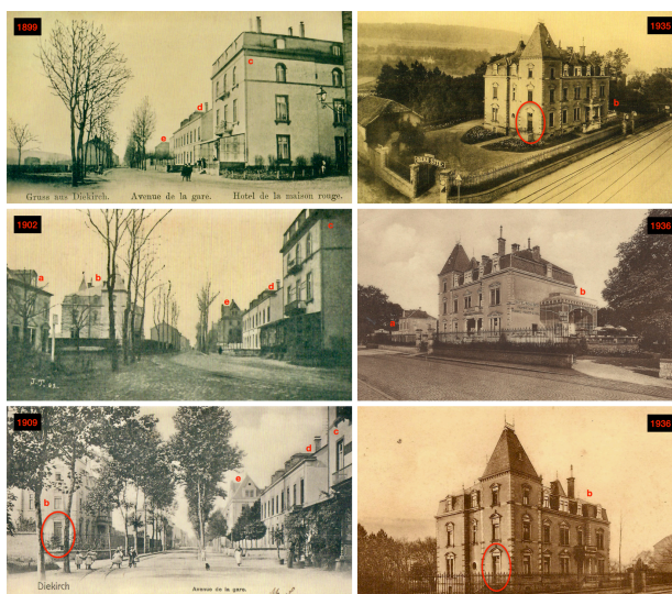
A gauche, la Villa RICHARD et à droite, l'Hôtel Beau-Site. L'entrée séparée à l'angle nord-est est signalée par un cercle rouge. Légende: a) Maison DEUTSCH (1895-1902), Maison BRÜCHER-KLEIN (1902-1909), Maison WELL-SCHOMMER (1909-1974), Bureau de Police puis enfin Recette municipale; b) Villa RICHARD (après 1900), Hôtel Beau-Site (après 1930), Hôtel de Ville (après 1959); c) Hôtel Maison Rouge renommé ultérieurement Hôtel du Parc; d) Gendarmerie (détruite pendant le 2e Guerre Mondiale); e) Gymnase respectivement Lycée classique de Diekirch. [Images: Cartes postales anciennes, collection_bp; Arrangement et légende: bp_2020-06-10]
