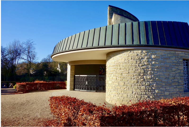
La chapelle ardente en colimaçon du nouveau cimetière de Diekirch au lieu-dit iwwer der Flossbaach imaginée par le bureau d'architecture JEGEN & GAUL, prend la succession de la Chapelle VANNERUS de l'ancien cimetière. [Photographie: bp_2016-12-03]
