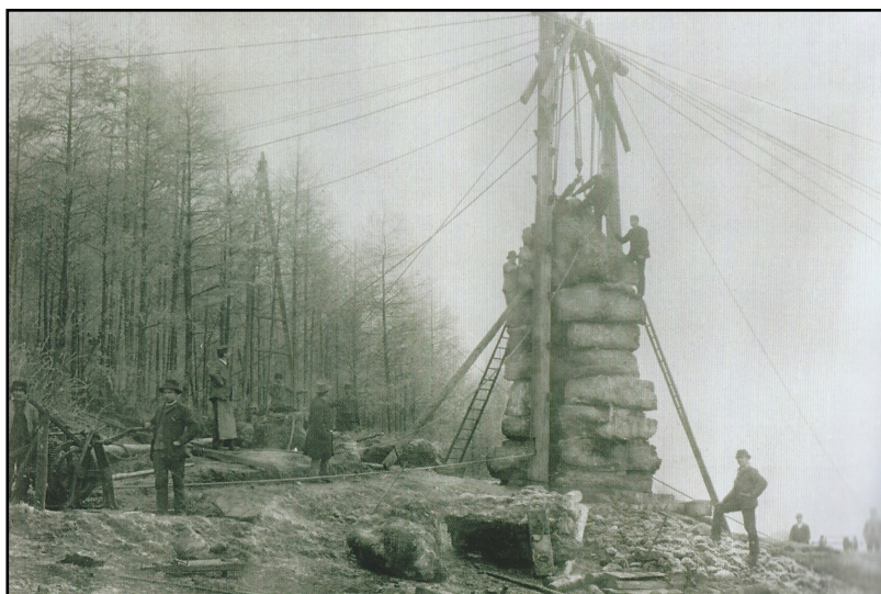
Deiwelselter, travaux de (re-)construction de 1892. [Photographie: NN_23.10.1892, in J. HERR, Diekirch, hier et aujourd'hui]
