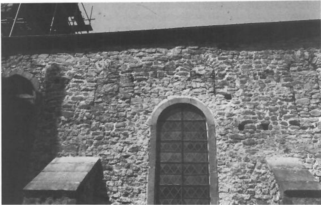
Abb. 10 Die südliche Außenfassade der Laurentiuskirche während der Restaurierungsarbeiten.
