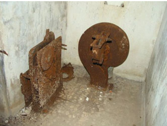
Le ventilateur (caserne principale)
