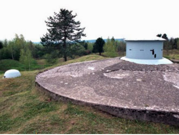
Tourelle de mitrailleuse de la caserne principale
