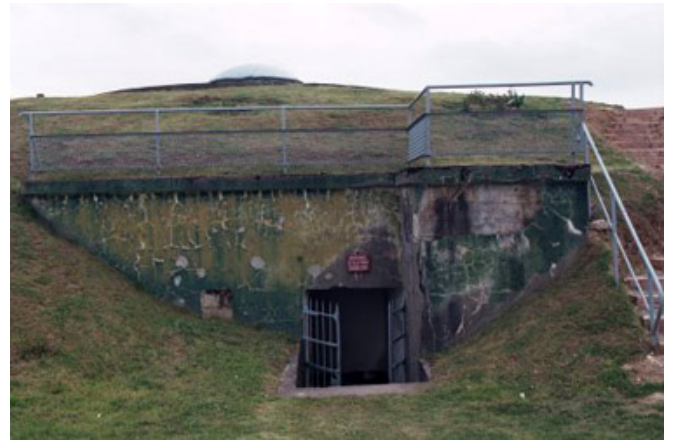
Entrée de la casemate
