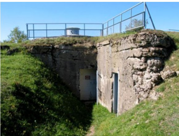
Entrée de la casemate
