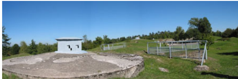
Seconde tourelle de mitrailleuses (à gauche de la casemate de 75)
