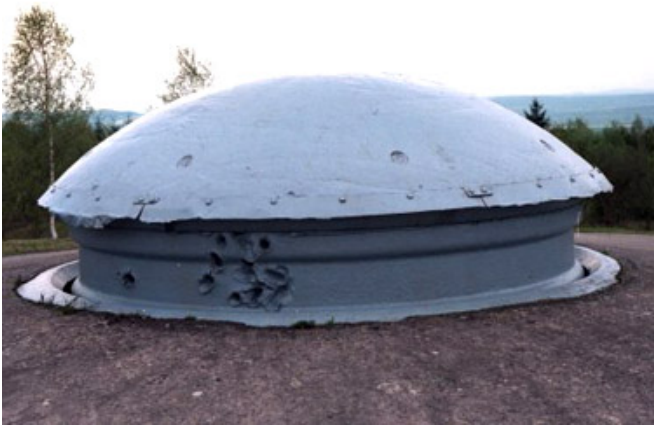
Tourelle rotative de canons de 75 mm (à gauche de la caserne principale)
