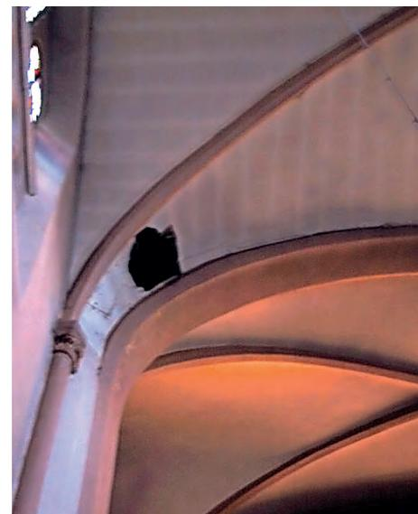
Bild 44: Deckendefekt im hinteren Teil des Mittelschiffes vor der Empore nach Gipsabfall am Tag der Oktave-Schlussprozession am 1. Mai 2005 [2005-05-01]
