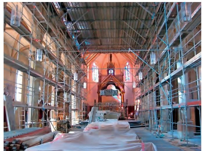
Bild 29: Instandsetzungsarbeiten im Innenraum der Dekanatskirche im Zuge der zweiten Umgestaltung (2009-2012): Verzicht auf kostspielige Baumaßnahmen zugunsten einer optischen, akustischen und funktionalen Aufwertung des Bestandes, insbesondere im „verwaisten“ architektonischen Chor [2012]
