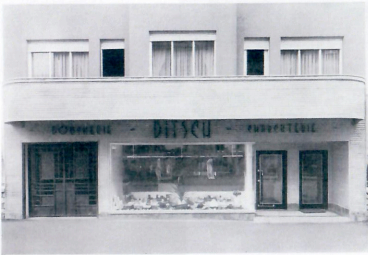
Neubau Ph. Ditsch, Diekirch
