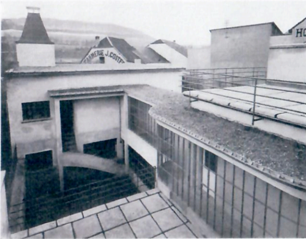
Neubau Ph. Ditsch, Diekirch
