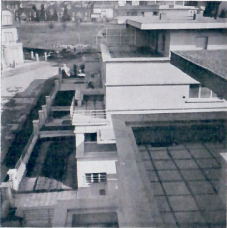
Dach und Terrassen der 2 Häusergruppen, Nassaustraße, Luxemburg
