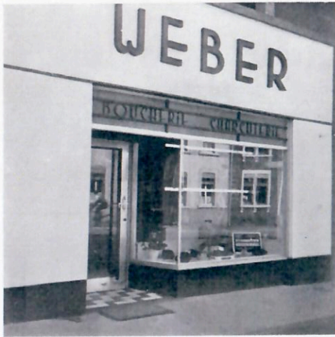
Umbau der Metzgerei Weber, Luxemburg-Ndf.
