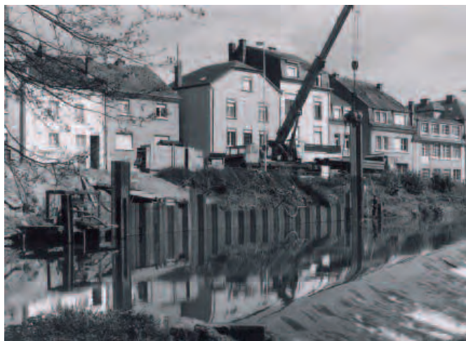
Der Bau der Uferbestigung dauerte von 1988 bis 1989. (Photo Arthur Muller)
