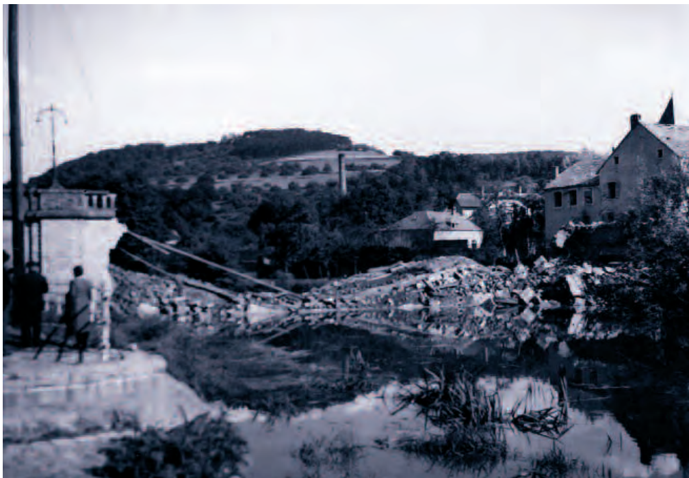
Die Alzettebrücke nach der Sprengung (Photo B. Berg, collection Ady Lambert)
