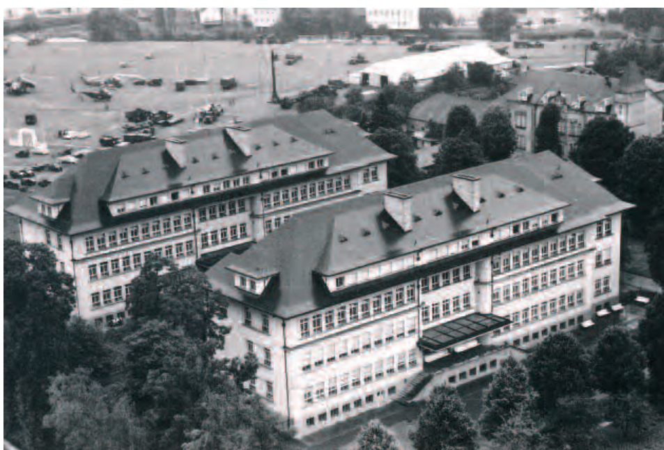
Die Ausschachtungsarbeiten für die zwei neuen Gebäude der Heilanstalt begannen im Jahre 1936. (Foto von 1960) (Photo Paul Faber, collection Arthur Muller)
