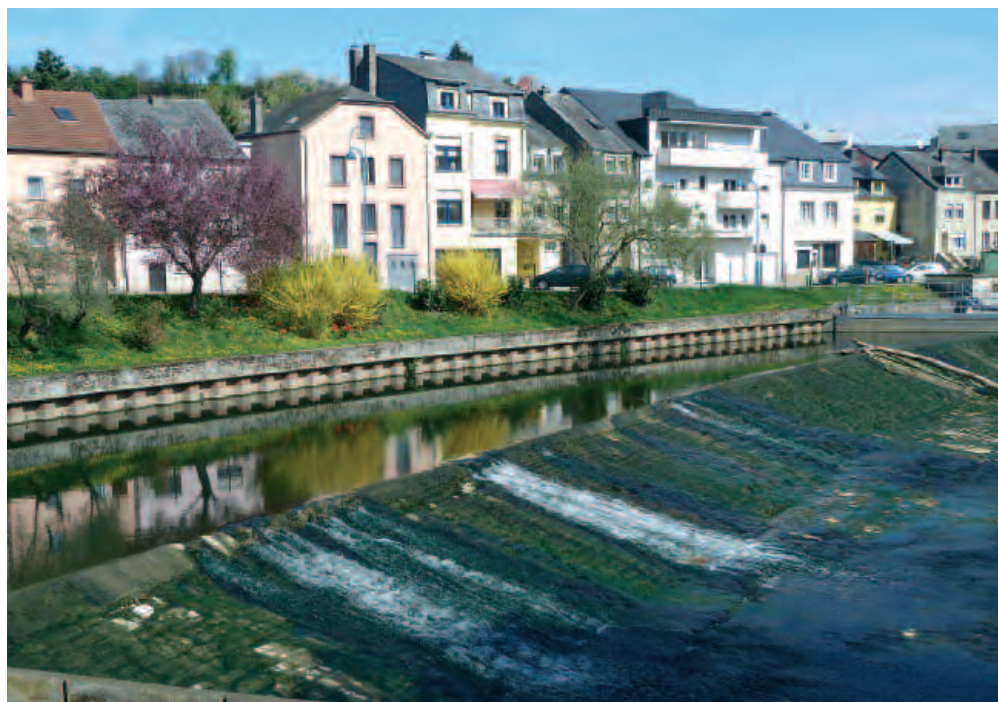
Das Alzettewehr heute. Immer wieder wurde im Lauf der Jahrhunderte daran gearbeitet. (Photo Arthur Muller)
