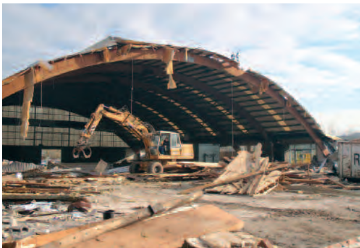
Der Abriss der alten Deichhalle im Jahre 2009 (Photo Pierrot Feltgen)
