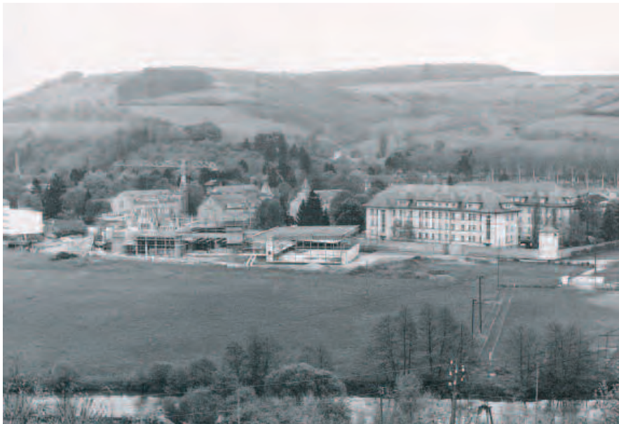
Hochhaus und Sporthalle im Bau (1965) (Photo Arthur Muller)
