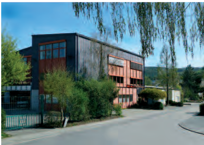
Das Nebengebäude des Centre National de Formation Continue (CNFPC). (Photo Arthur Muller)
