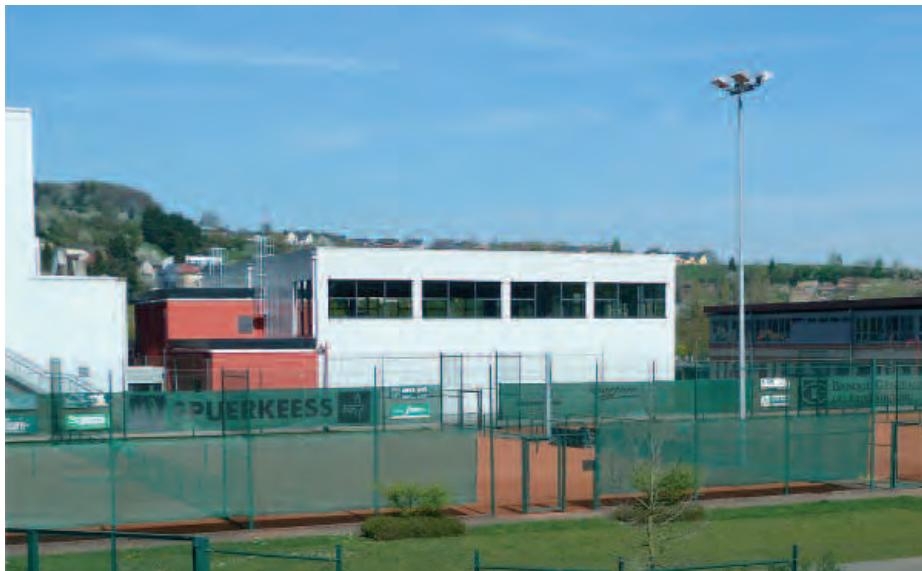
Seit 2009 ist die Turnhalle in Betrieb. (Photo Arthur Muller)
