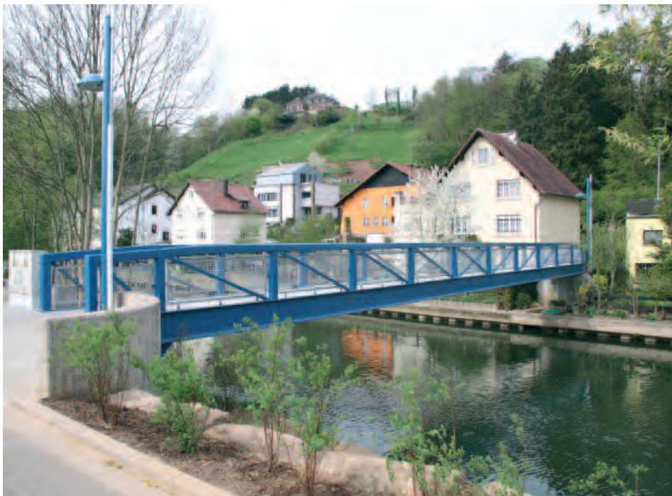
Die neue Fußgängerbrücke (Photo Pierrot Feltgen)
