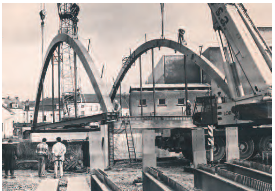
Die Montage der Bogenbrücke im November 1992 (Photo Armand Thill, collection Arthur Muller)
