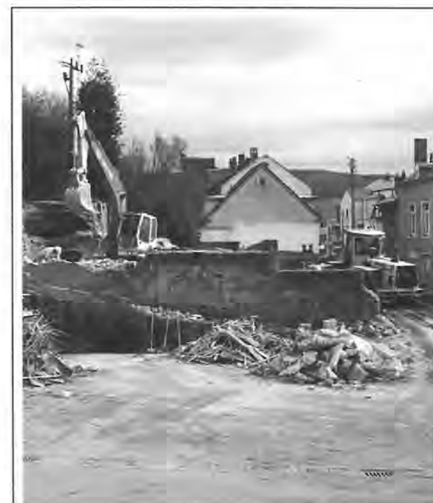
Construction d'un "Parkhaus" démolition de l'ancienne maison Nosbusch (29.02.96)
