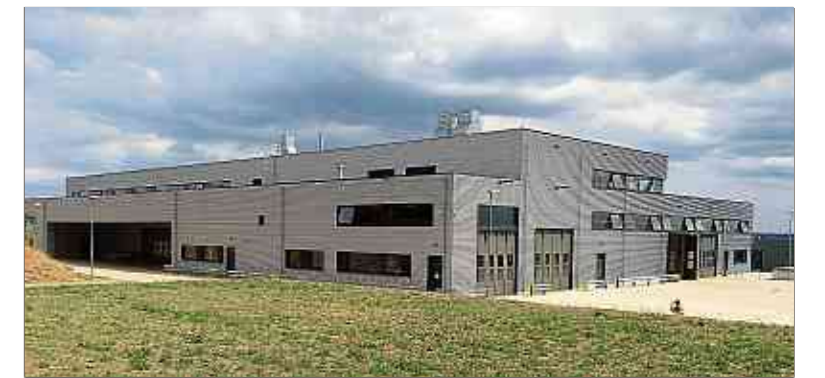
In der neuen logistischen Halle sind u. a. auch rund 94 000 verschiedene Artikel untergebracht. (FOTOS: NICO MULLER)
