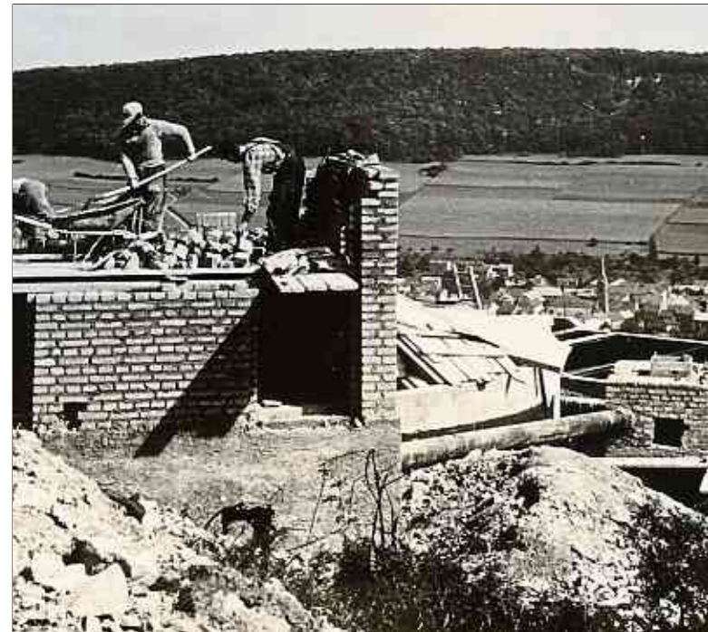
Körperliche Schwerstarbeit hoch über den Dächern der Stadt Diekirch.
