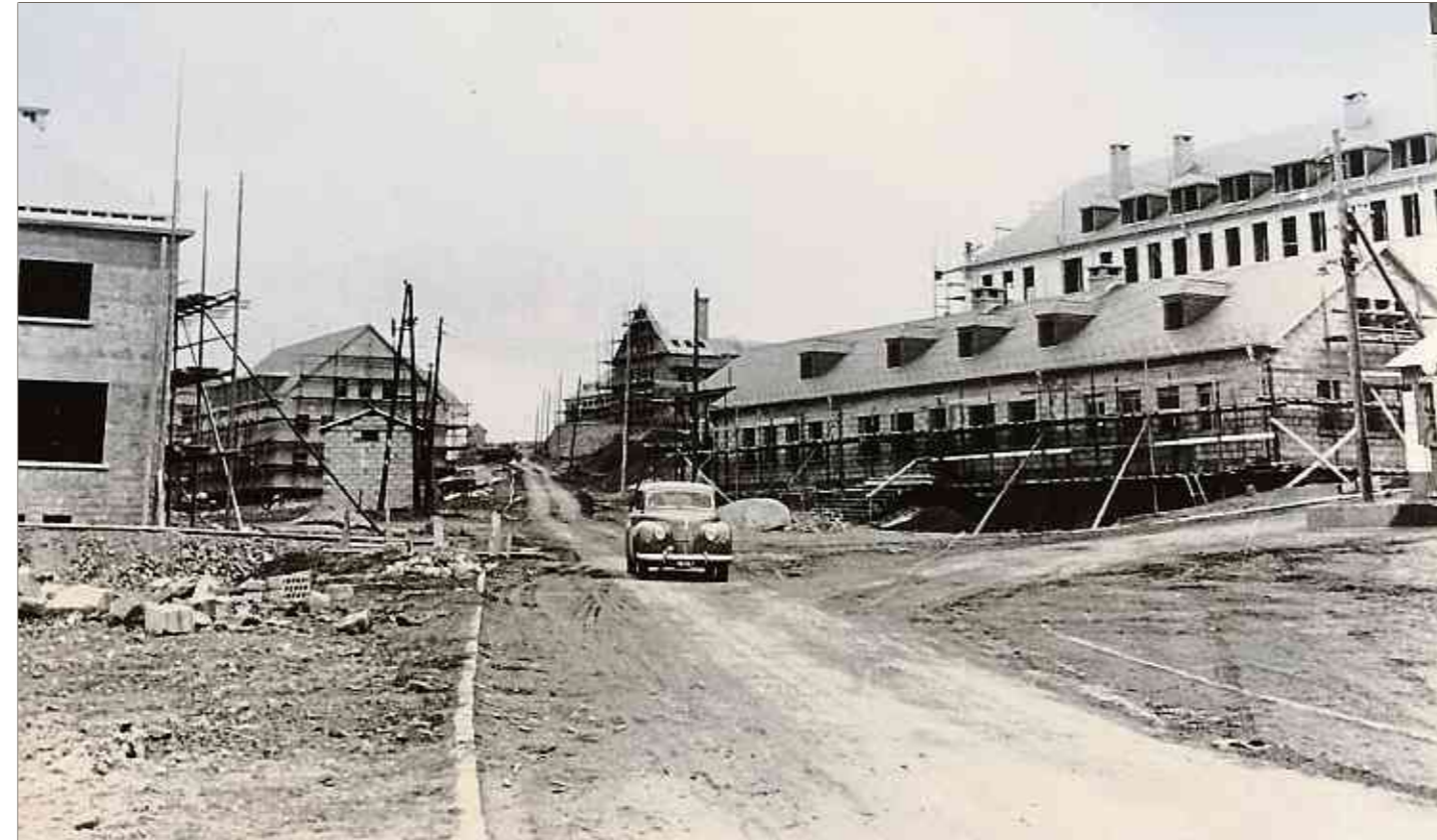
Blick auf die im Bau befindlichen Gebäude ab dem Wachhäuschen am Eingang der Kaserne, vor über 60 Jahren.
