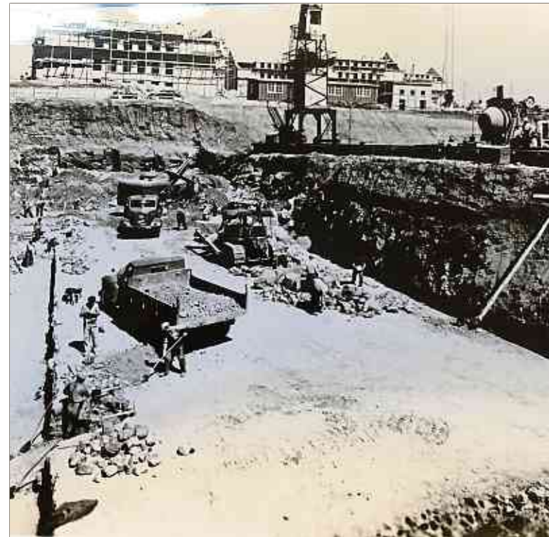
Großbaustelle Herrenberg: Acht Bauunternehmen waren daran beteiligt.
