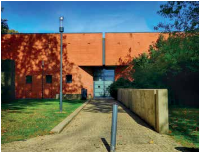
Abb. 9: Krematorium Luxemburg-Hamm, Haupteingang an der Südseite. Foto: © JPRemiche, 2018.
