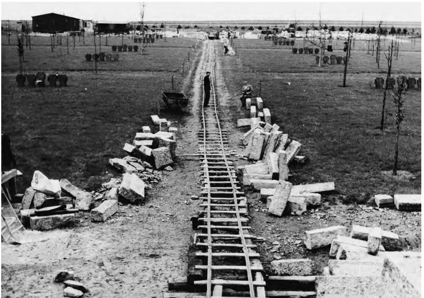
Abb. 7: Bau der zentralen Achse zum Hochkreuz hin. Bildquelle: Bildarchiv des VBK-Kassel.
