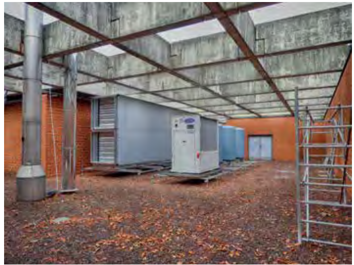
Abb. 7: Krematorium Luxemburg-Hamm, offenes Dachgeschoss mit Betonbalken. Foto: © JPRemiche, 2018.
