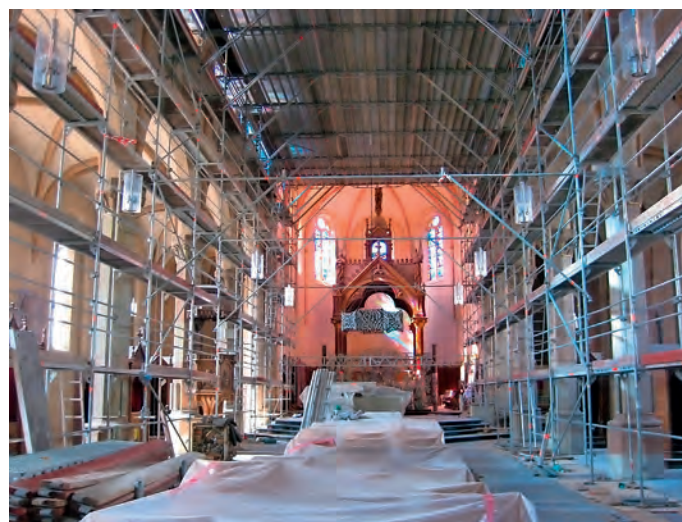
Bild 29: Instandsetzungsarbeiten im Innenraum der Dekanatskirche im Zuge der zweiten Umgestaltung (2009-2012): Verzicht auf kostspielige Baumaßnahmen zugunsten einer optischen, akustischen und funktionalen Aufwertung des Bestandes, insbesondere im „verwaisten“ architektonischen Chor [2012]
